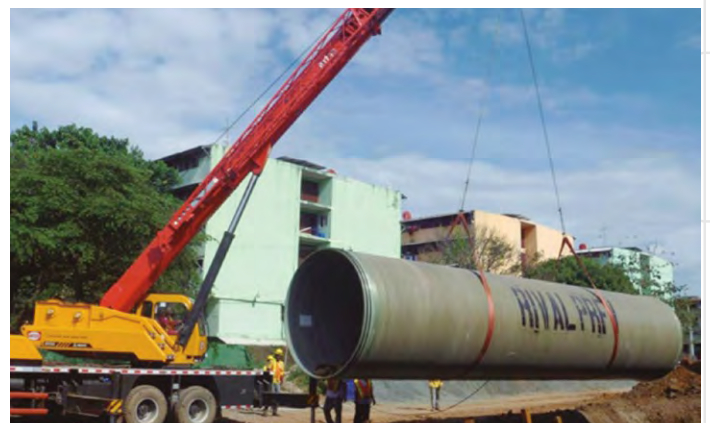
Obra Alcantarillado Pluvial Av. Panana, Panama.
